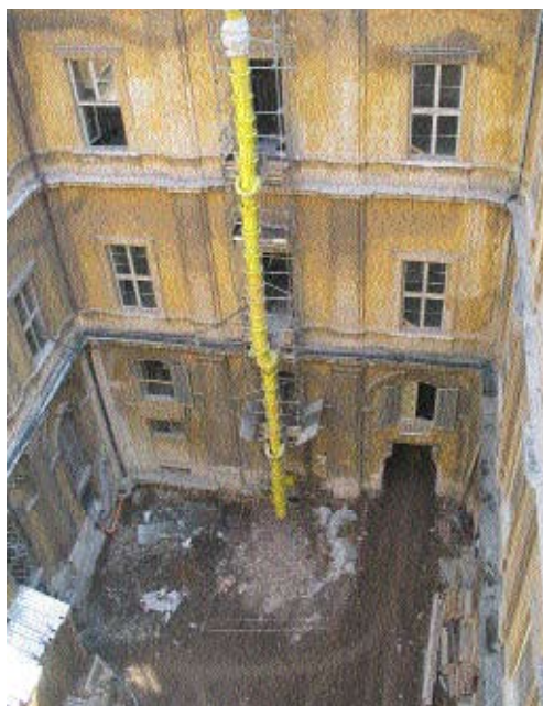
cortile interno del palazzo dell'Apollinare. Sotto sarà realizzata la nuova Aula Magna
